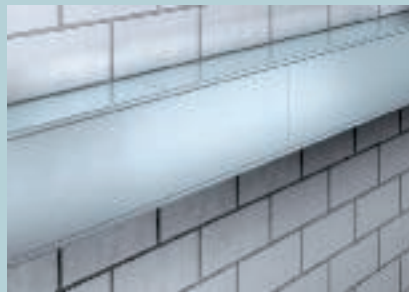
Fugenversatz für mehr Stabilität
