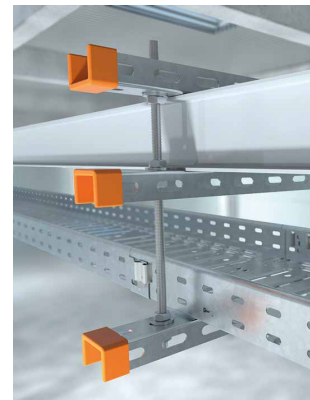
Beschichteter Stahlträger mit einer geklemmten Konstruktion zur Aufnahme des Tragsystems
