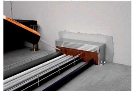
Zwischenräume mit PYROSIT® NG Brandschutzschaum komplett verschließen
