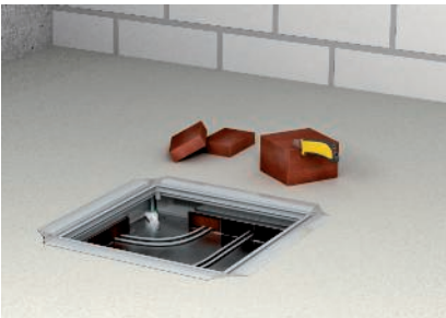
Schmale Streifen für die Kanalzüge zuschneiden.
