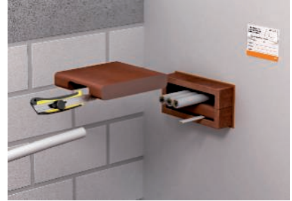
Passgenaues Zuschneiden der Innenteile und Einsetzen in den Rahmen.
