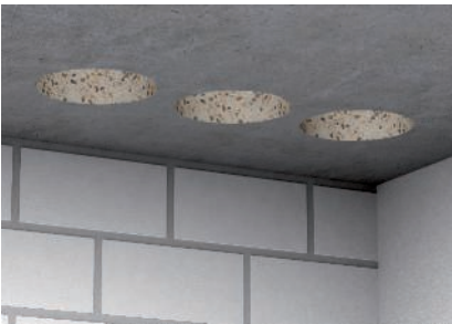
Geringer Abstand zur nächsten Kernbohrung möglich.
