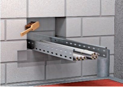
Laibung reinigen und Schalungshilfen, zum Beispiel Klebeband, anbringen.
