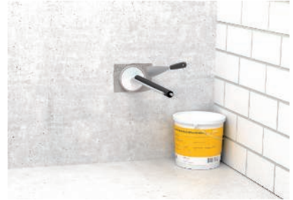
Anpassung Schaumstoffstopfen an Installationen mit einem Messer und rauchgasdichte Versiegelung der Oberflächen mit Beschichtungsmasse ASX.
