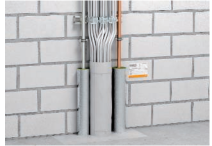
Installation der Brandschutzbandage mit Nullabstand zur Rockwool Conlit Rohrabschottung.
