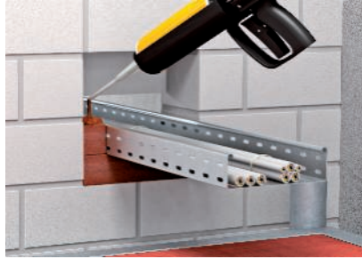
Schaum von hinten nach vorne einbringen, Reste optional entfernen.
