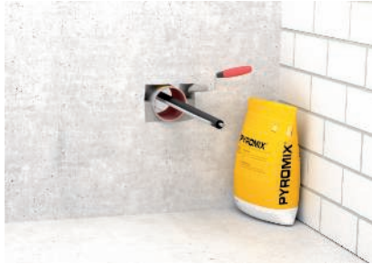
Verschließen der Öffnung mit Mörtel PYROMIX®.
