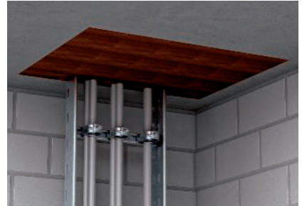
Strammsitzender Einbau der Blöcke im Deckendurchbruch.
