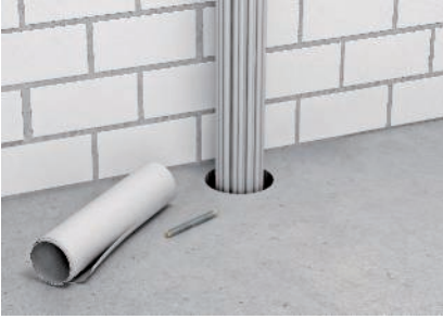
Vorbereitung der Kabelabschottung.
