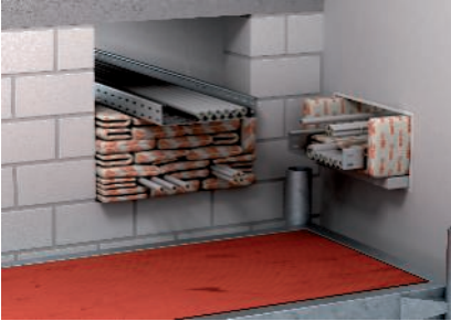
Verschließen der Öffnung mit Kissen - ohne Spachtelmasse oder Anstrich.
