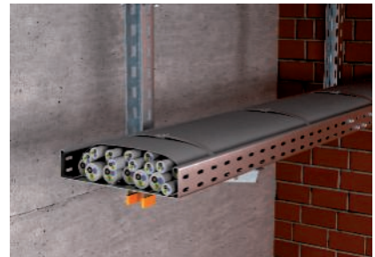
Bandagierung der Kabelbündel auf Tragsystemen.
