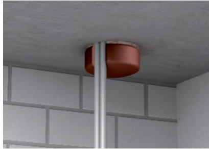
Zuschneiden und montieren der Stopfen in Decken.
