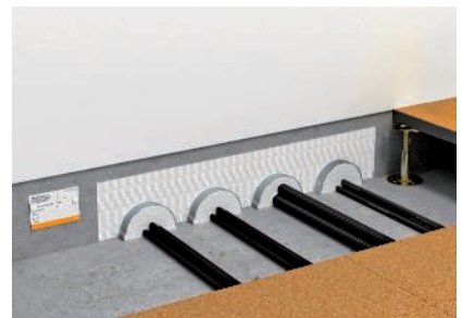
Fertig installierte Halbschale im Weichschott PYROPLATE® Fibre.
