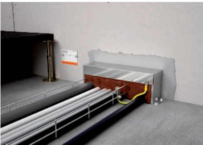
Potentialausgleich anschließen und Kennzeichnungsschild anbringen
