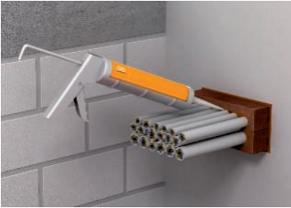
Abschließender Fugenverschluss bei Vollbelegung mit Spachtelmasse FBA-SP.
