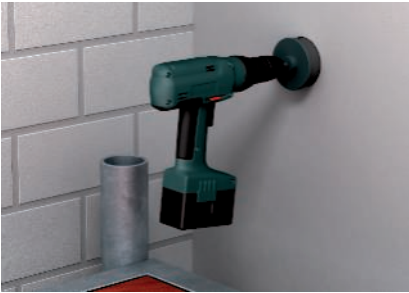
Bohren eines Lochs mit einem Dosenbohrer.
