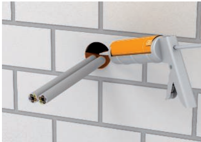
Verschließen der Öffnung mit der Spachtelmasse FBA-SP.
