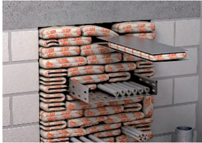
Bleche als Montagehilfe für die letzte Kissenschicht.
