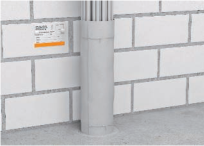
Mit Mörtel die restliche Schottöffnung verschließen und das Kennzeichnungsschild montieren.
