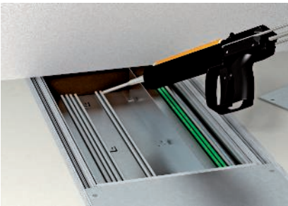
Einbringen des Brandschutzschaums direkt unter der Wand.
